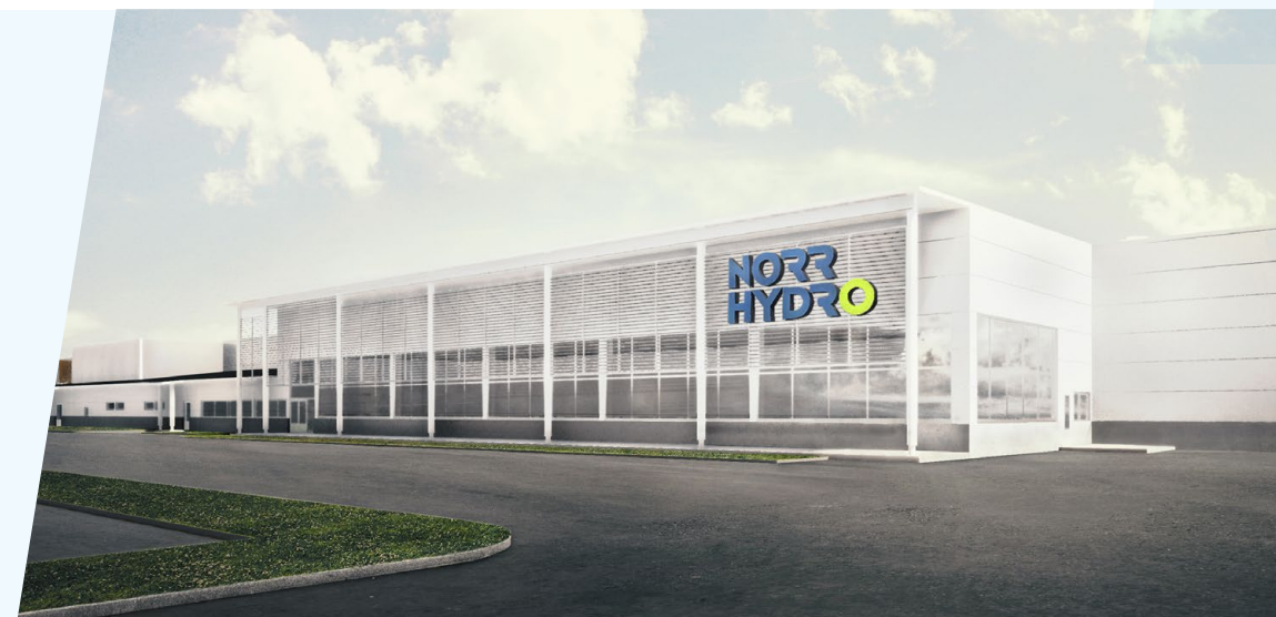
Norrhydron uusi, ympäristöystävällinen tuotantolaitos valmistuu vuoden 2022 loppupuoliskolla Rovaniemelle.
